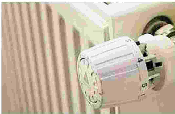
Un termosifone con termovalvola
