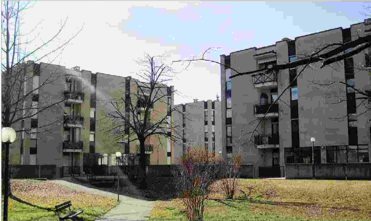
Anche Itea spa non è in grado di rispettare il termine di adeguamento degli impianti. Nella foto, edifici Itea di via Terra Nera a Mori
