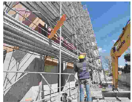
COSTRUIRE Operaio in un cantiere edile
