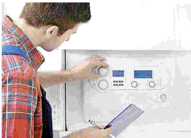
In alto i pregiati palazzi di piazza Vittoria, sotto un tecnico sui termosifoni
