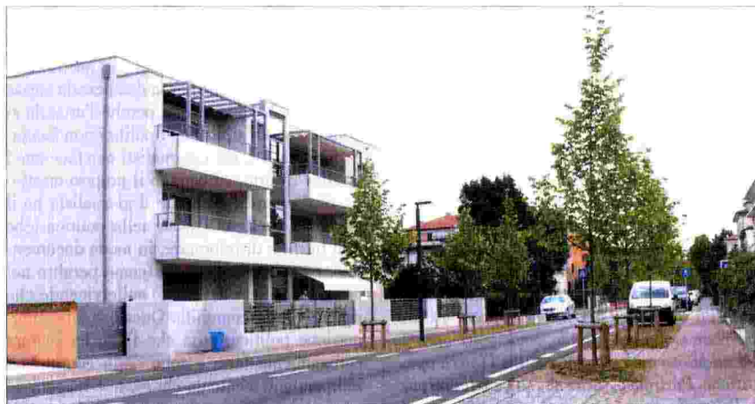
Nuove costruzioni in via Barbiero
