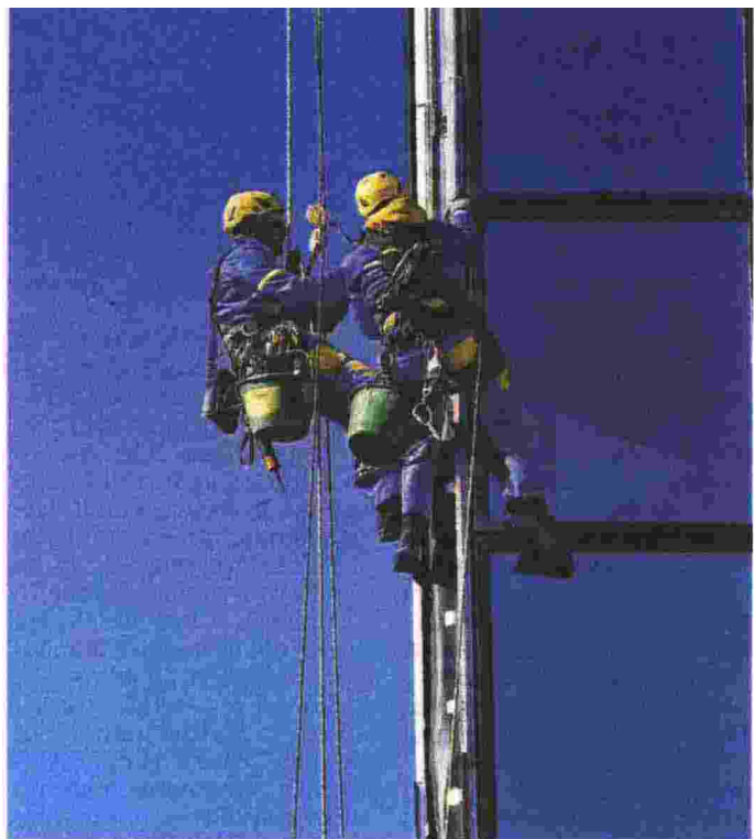
CANTIERI Il settore edilizio vale il 4,3% del Pil italiano
