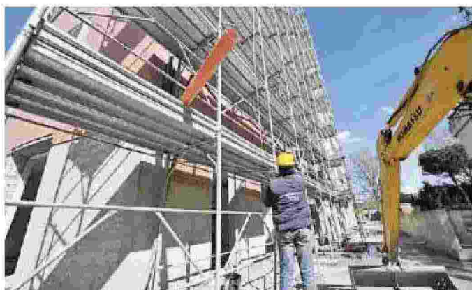
Un cantiere edile
