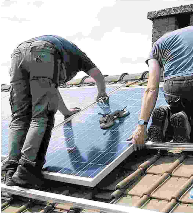
Il montaggio dei pannelli solari sui tetti di un'abitazione
