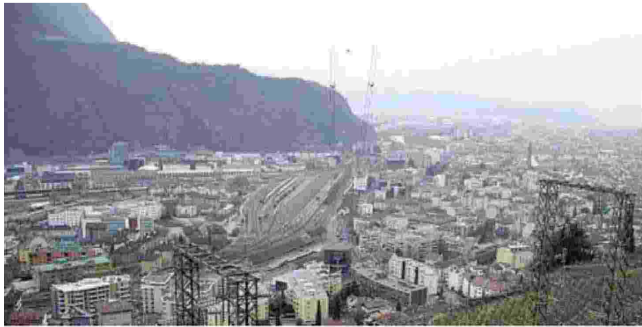
Abitazioni Una veduta aerea di Bolzano: il comune ha ridotto allo 0,9% le aliquote Imi per chi affitta. Se la casa va a studenti si paga solo lo 0,7%
