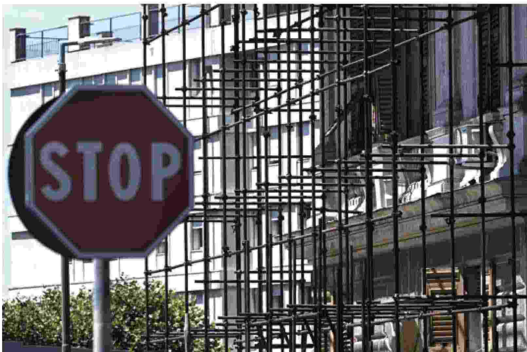
Un edificio in corso di ristrutturazione ANSA
